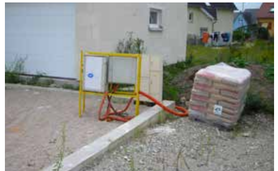
Stockage aux emplacements dédiés
