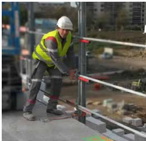
Protections fixées sur dalles
