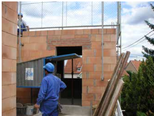
Protections fixées dans la maçonnerie
