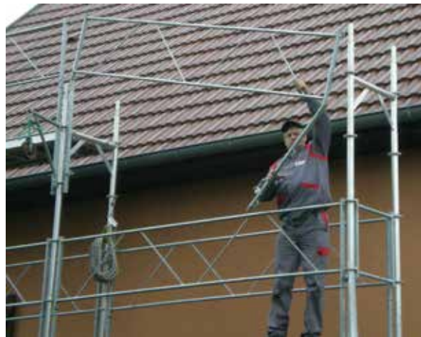
Echafaudage à montage en sécurité
