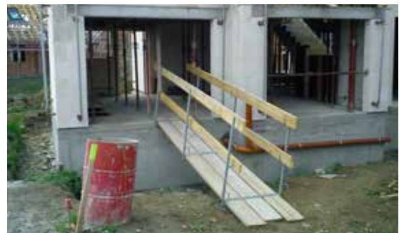
Passerelle stable et protégée
