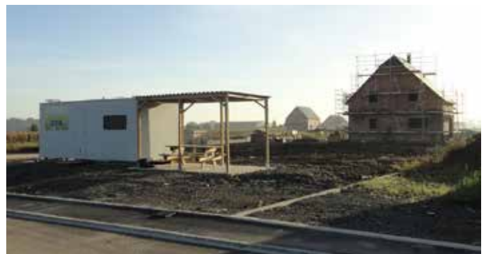
Exemple de base vie de lotissement
