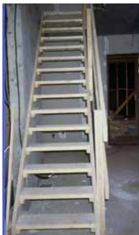
Escalier provisoire avec garde-corps en bord de dalle
