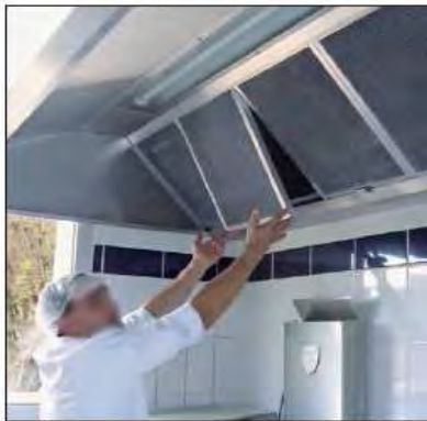
Démontage de plain-pied d'un filtre de hotte.
