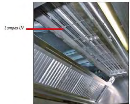
Hotte d'aspiration avec système à lampes UV.
