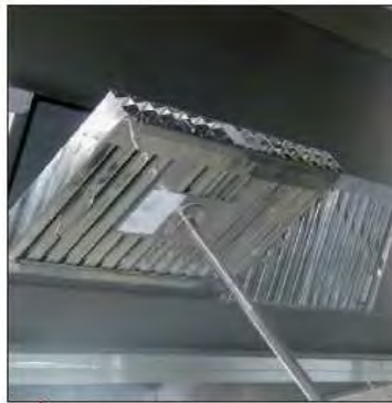
Outil de démontage/remontage du filtre en position.
