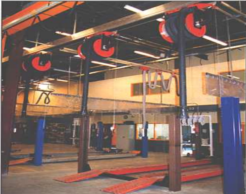
Dispositif d'aspiration de fumée équipé d'enrouleur automatique
