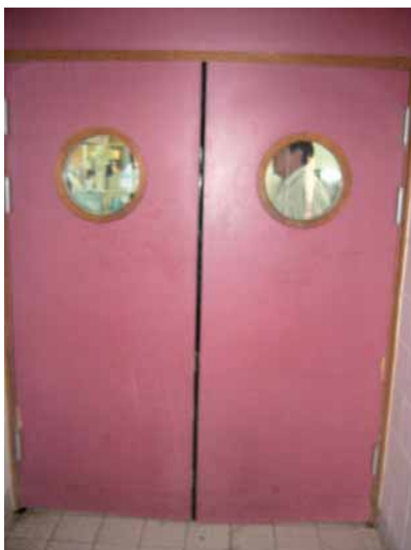
Accès entre salle et cuisine: porte battante disposant de hublot réduisant fortement le risque de heurt
