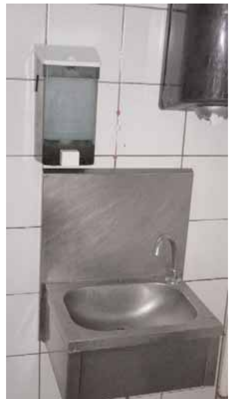
Lave-mains à commande non-manuelle
